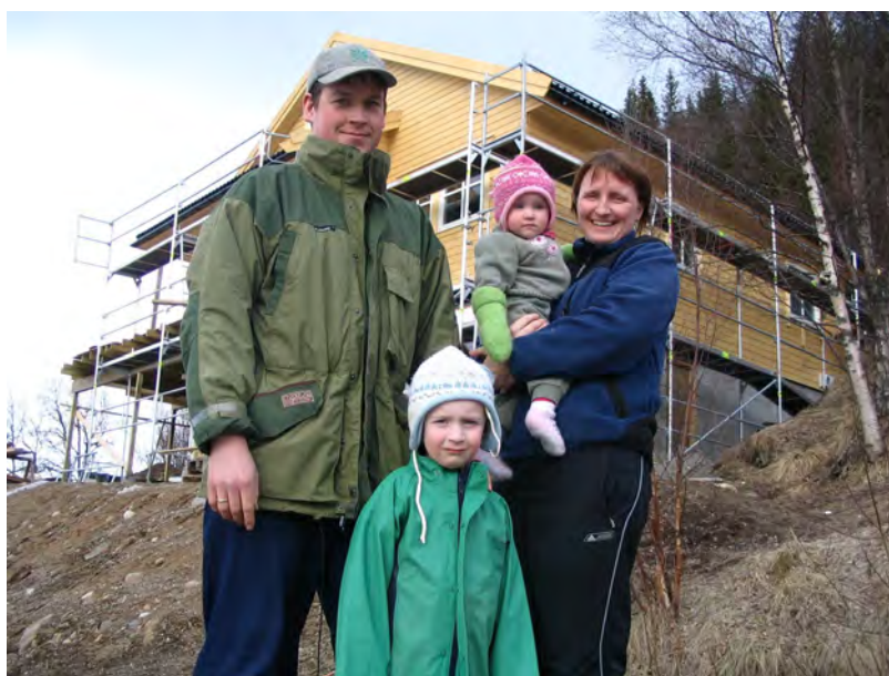
Kjetil, Sindre, Cathrine med Siri Elise 10 mnd på armen, foran sitt nye hus som er under oppføring på utkikkstomta i Stiskardet.
